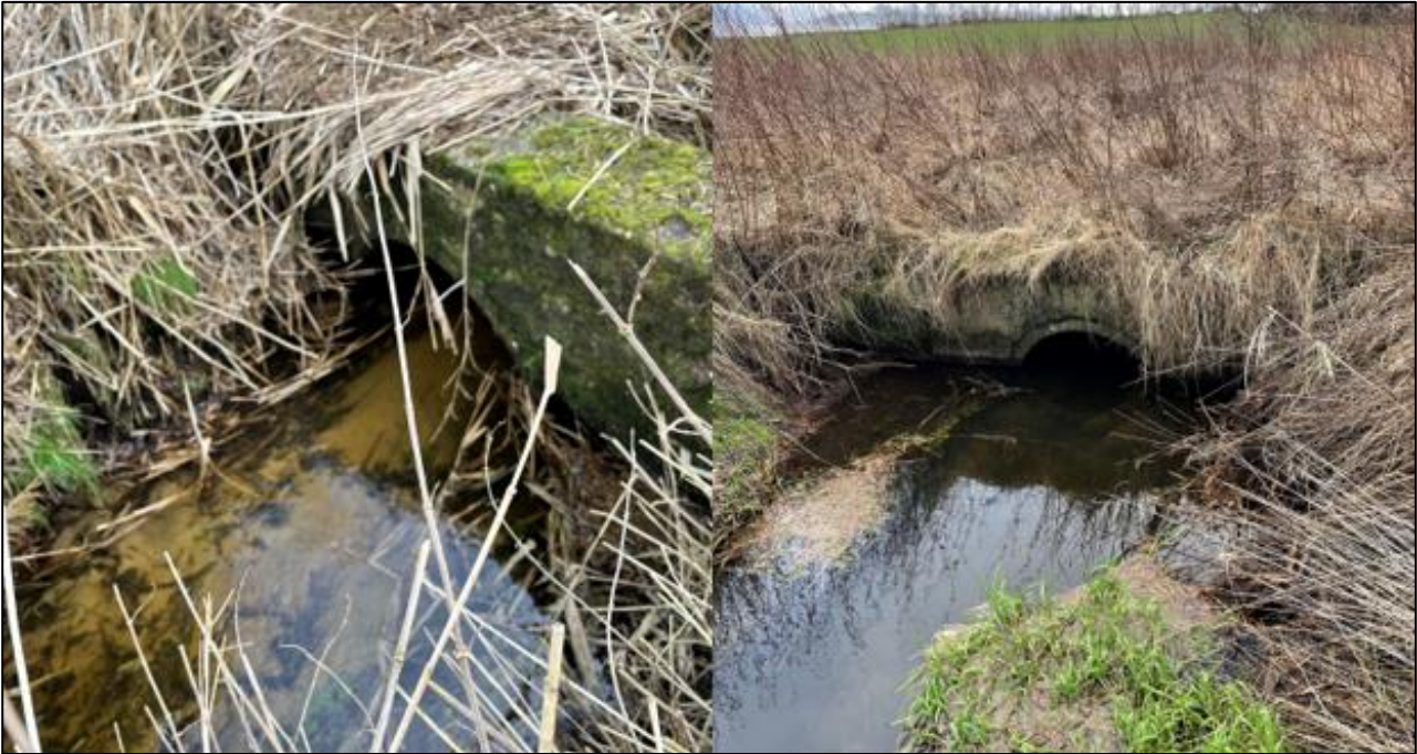
Figur 5: 1969-2229: Venstre: Indløb til rørlægning. Højre: Udløb fra rørlægning.
